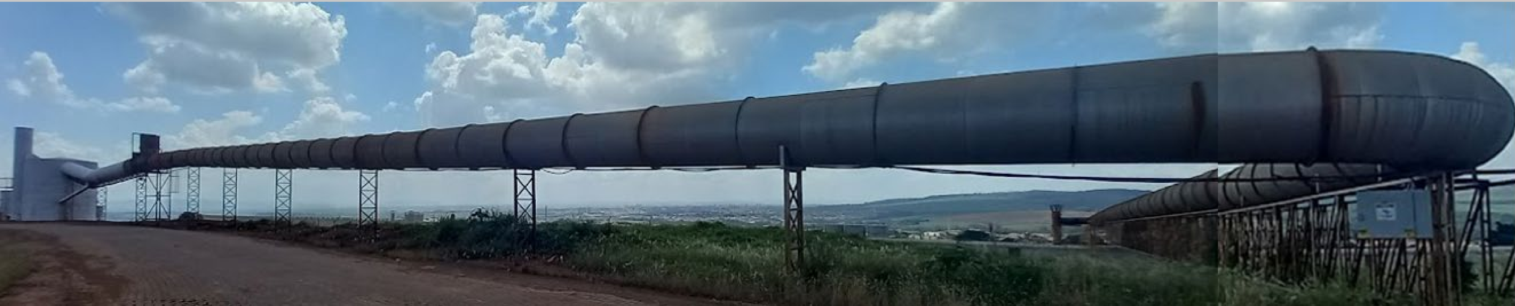
Condição da estrutura em maio de 2022
