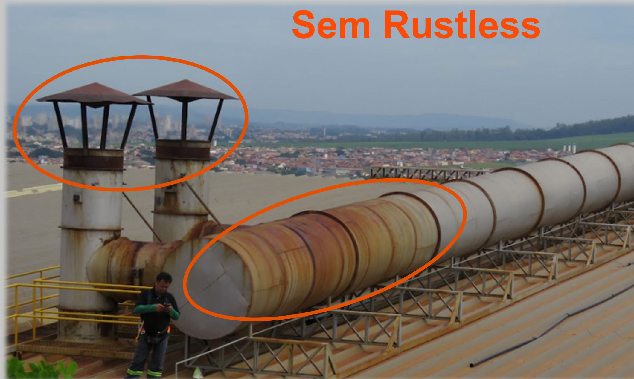
Condição da estrutura anterior à instalação da tecnologia anticorrosiva.
