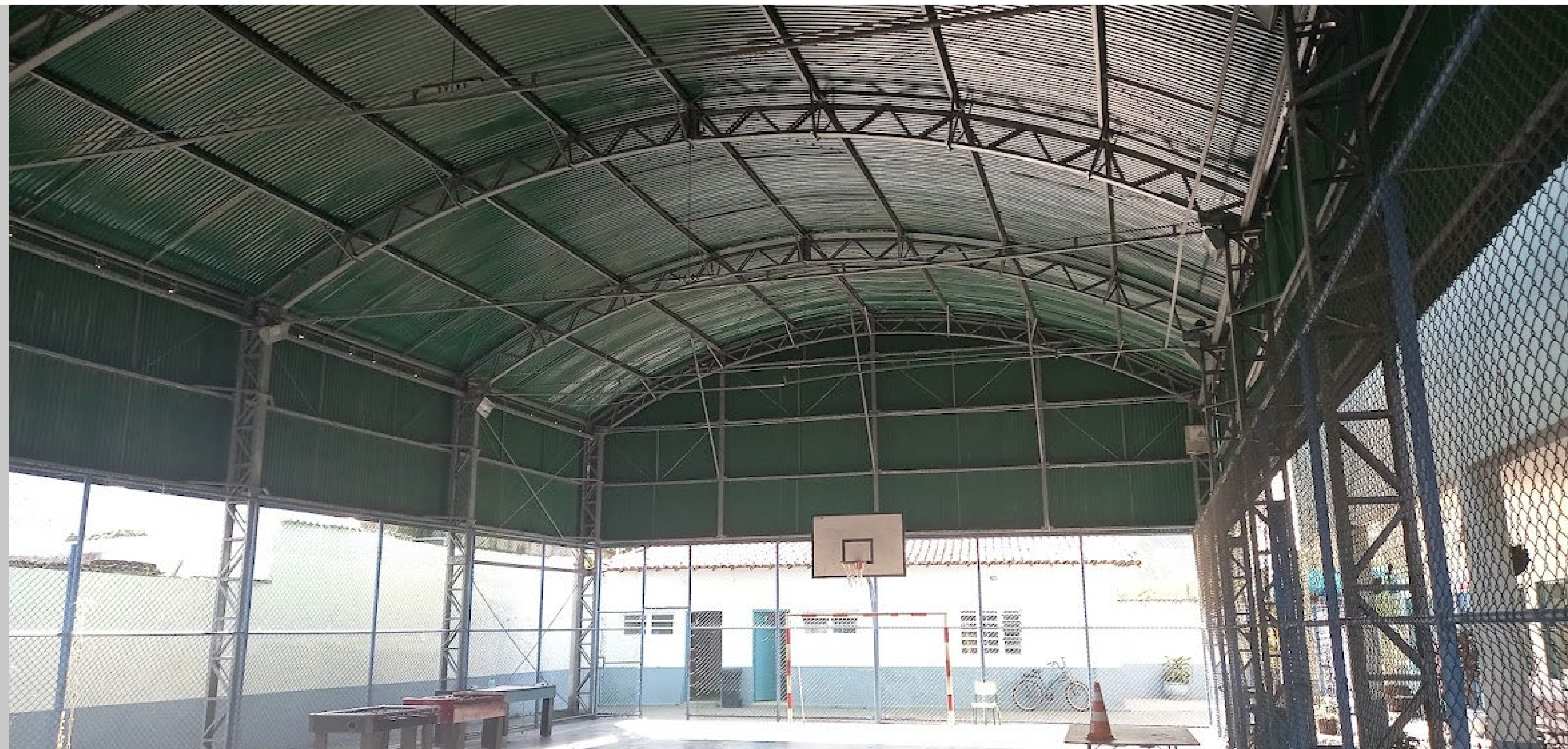
Estrutura preservada e protegida pela Rustless - E.M. Henrique Botelho. – Novembro 2021
